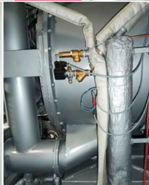
Heizpatrone Dampferzeugung
